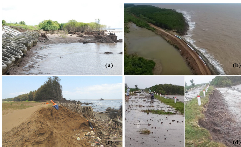
Hình 7. Dải rừng ngập mặn ven biển tiêu biến làm lộ tuyến đê đất: (a) Gò Công, Tiền Giang; (b) Vĩnh Châu, Sóc Trăng; (c) Bạc Liêu; (d) Cà Mau.
