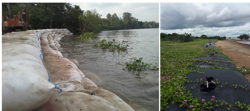
Hình 17. Kè bảo vệ bằng túi và ống.
